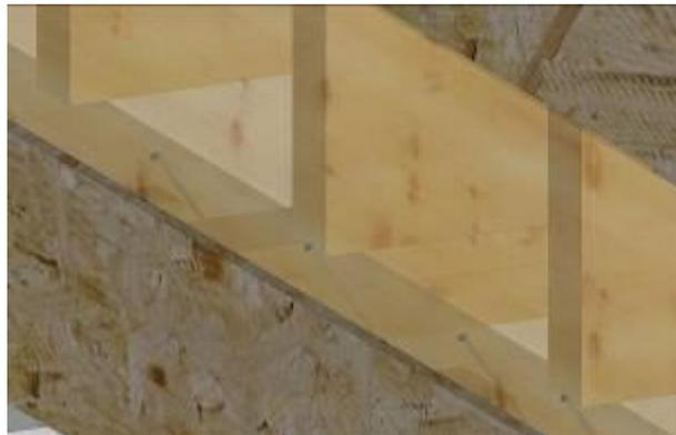
**Figure 6-24** : Détail de liaison entre le plancher et les murs de contreventement
